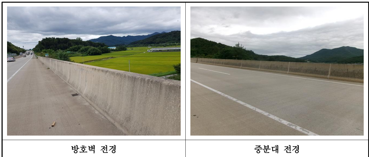
【사진 7.3.52】 방호벽 및 중분대 전경
