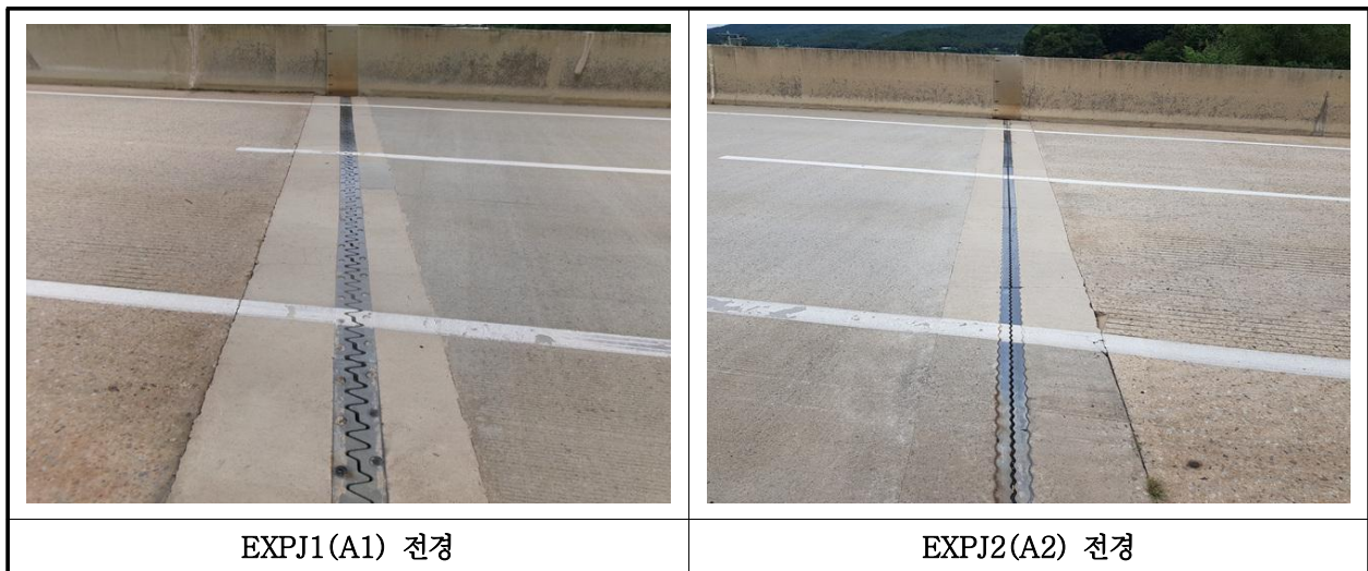
【사진 7.3.44】 신축이음장치 전경
