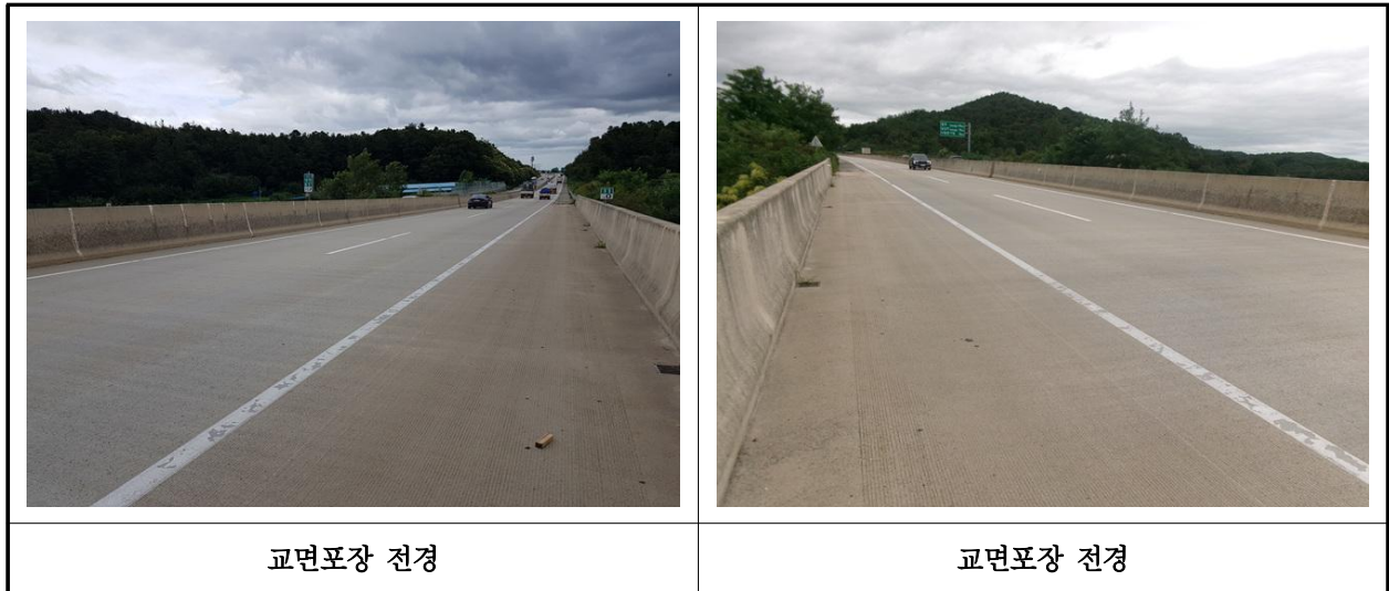
【사진 7.3.47】 교면포장 전경
