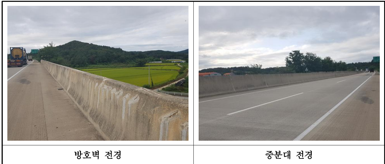
【사진 7.3.24】 방호벽 및 중분대 전경
