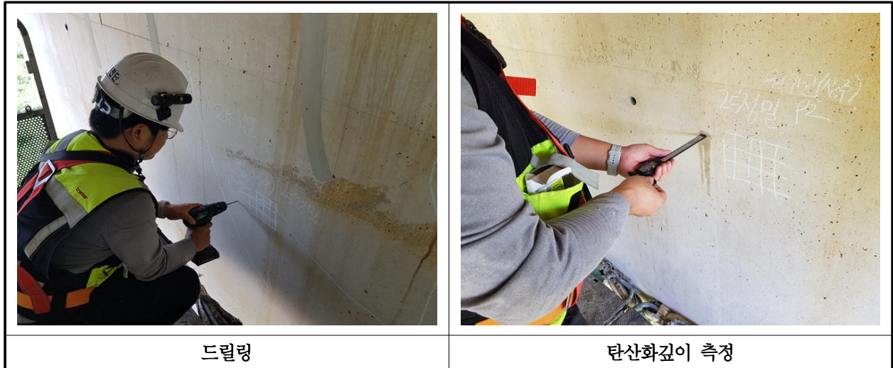
【사진 7.4.3】 탄산화 깊이 측정 현장사진
