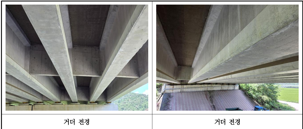
【사진 7.3.4】 거더 전경
