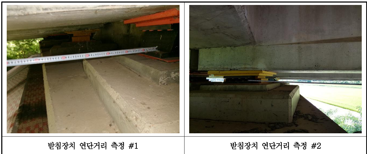
【사진 7.3.15】 교량받침장치 연단거리측정
