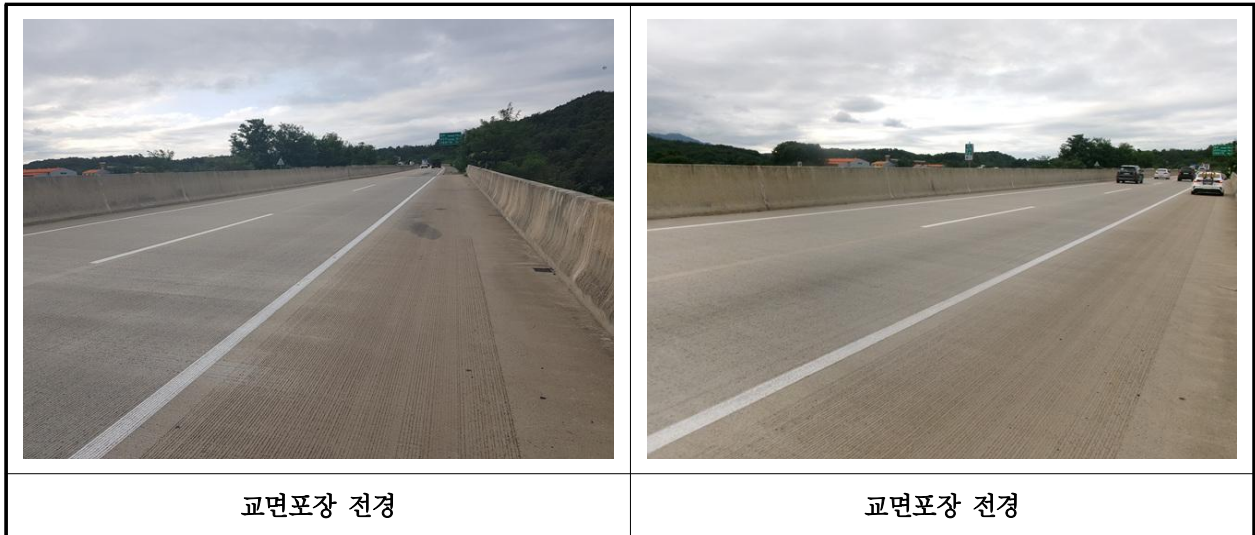
【사진 7.3.20】 교면포장 전경
