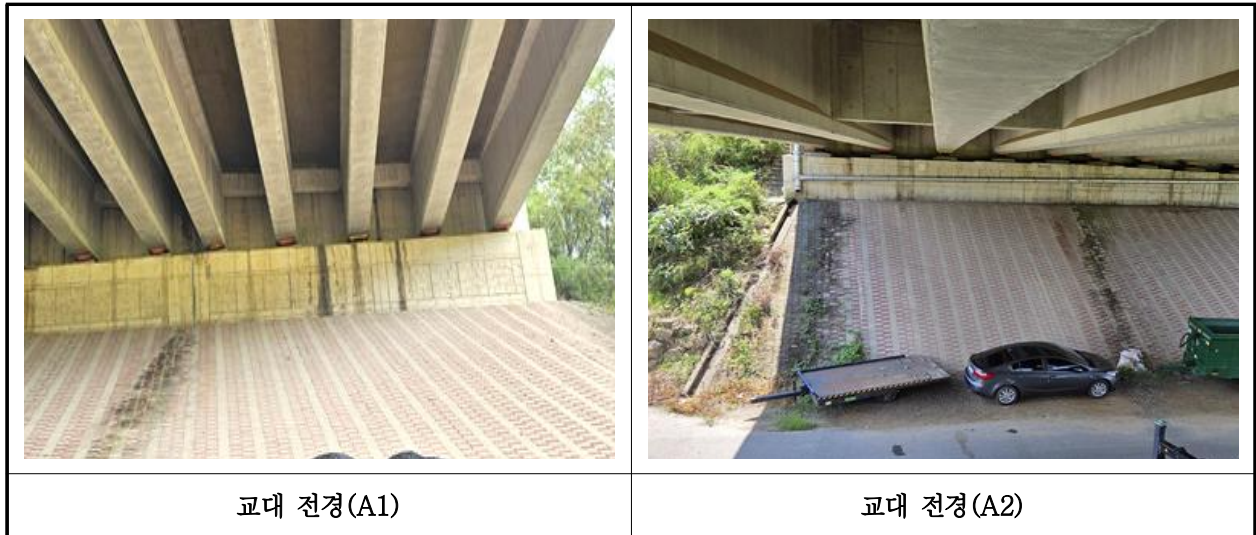
【사진 7.3.8】 교대 전경
