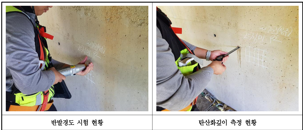
【사진 7.4.1】 콘크리트 내구성조사 현황
