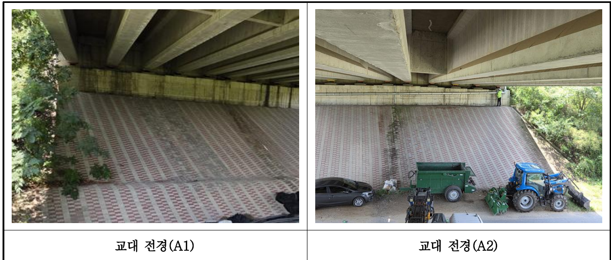
【사진 7.3.35】 교대 전경
