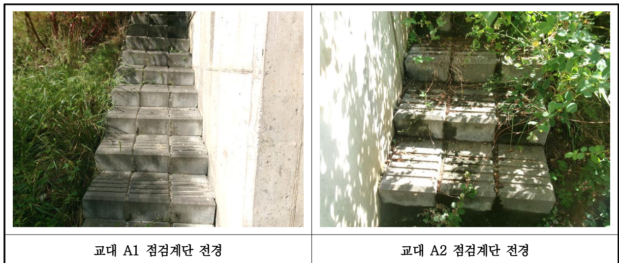
【사진 7.3.54】 교량 점검시설 전경
