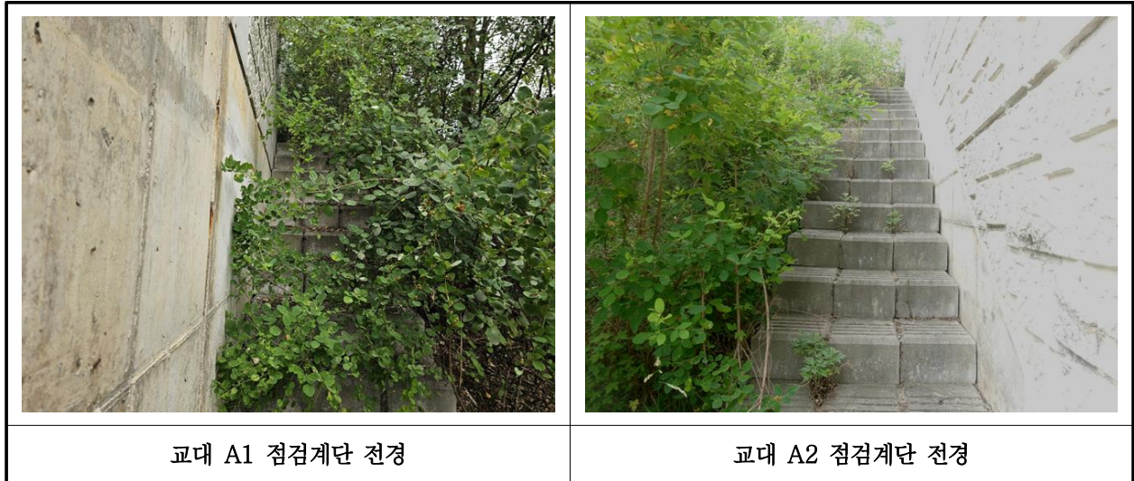
【사진 7.3.26】교량 점검시설 전경
