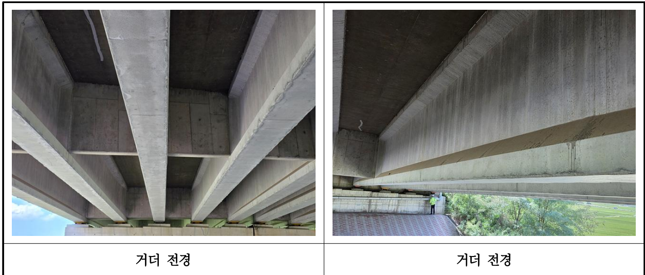
【사진 7.3.31】 거더 전경
