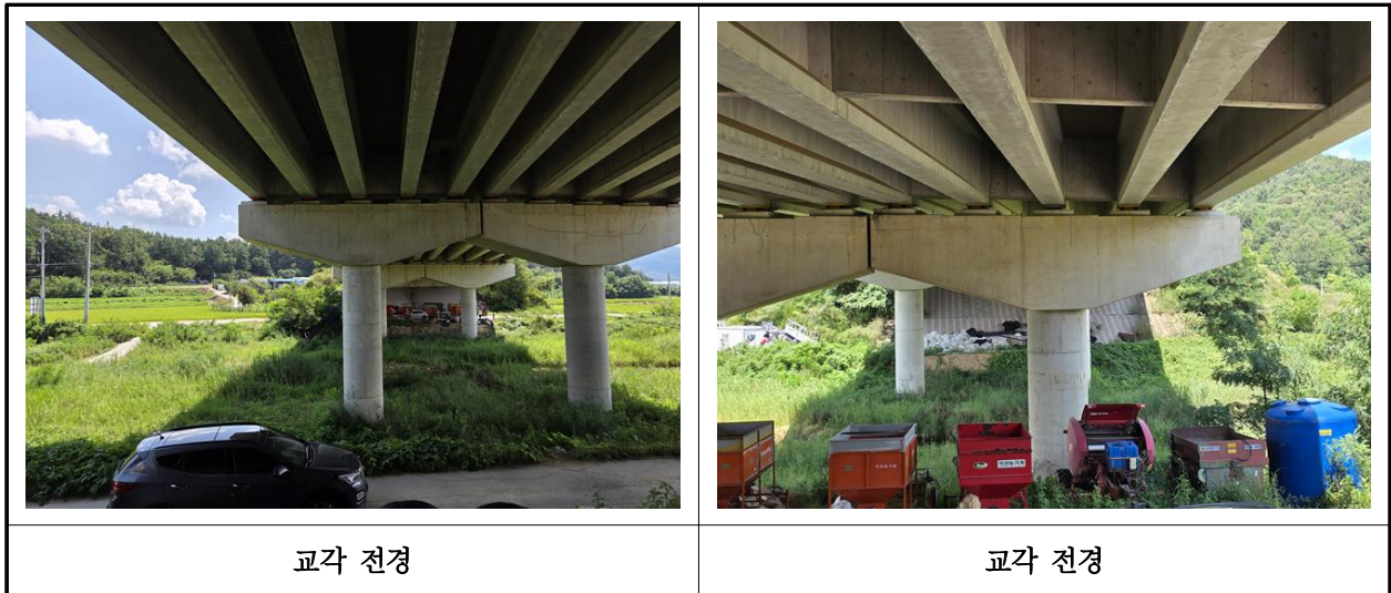
【사진 7.3.10】 교각 전경
