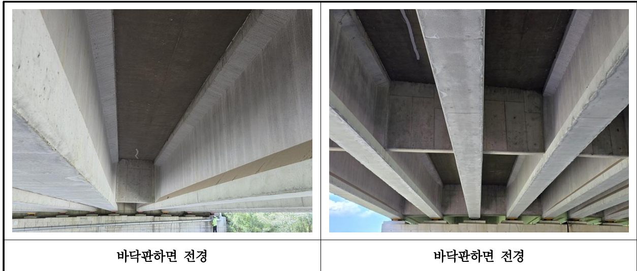
【사진 7.3.29】 바닥판하면 전경
