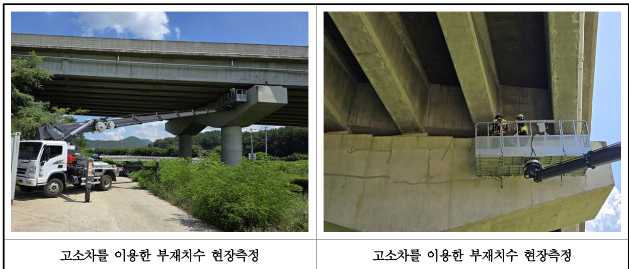
【사진 7.2.1】 부재 현장측정 전경
