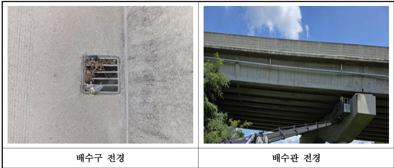
【사진 7.3.50】 배수시설 전경
