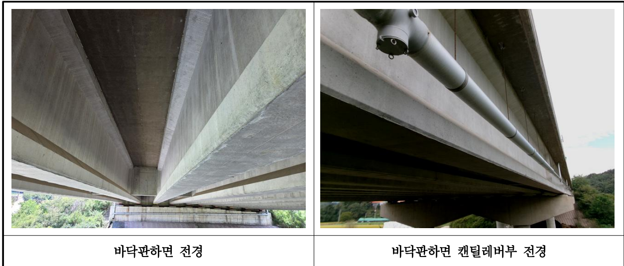
【사진 7.3.2】 바닥판하면 전경
