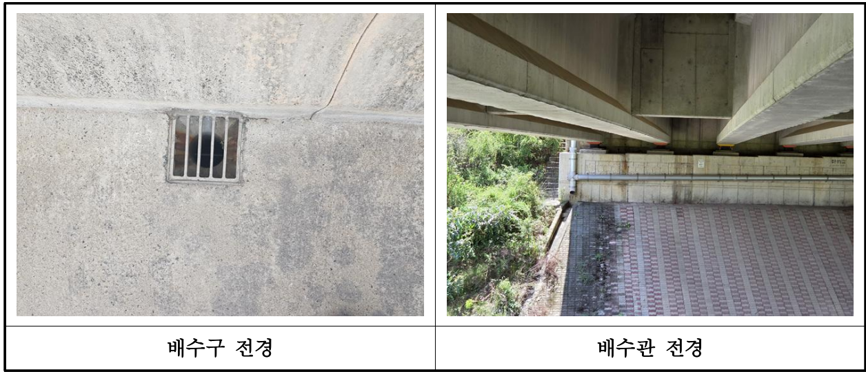
【사진 7.3.22】 배수시설 전경
