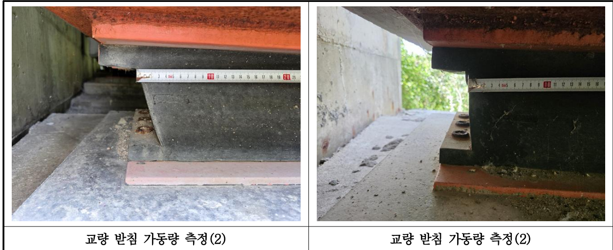
【사진 7.3.43】 교량받침 이동량 측정
